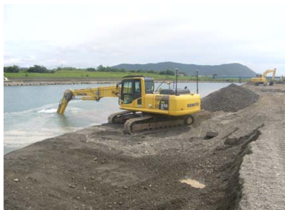
1号機掘削状況
