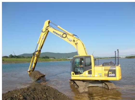
2号機掘削状況
